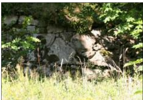
Des blocs de granite cyclopéens
