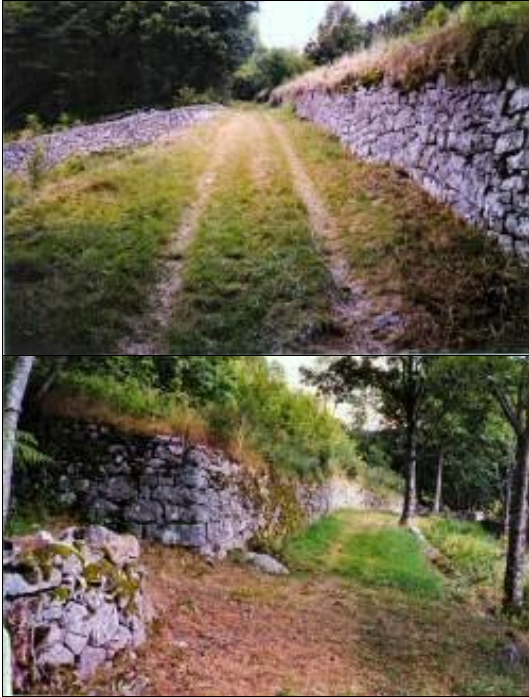
Qualité de l'assemblage des blocs de granite
