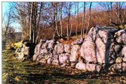
Des blocs de granite cyclopéens
