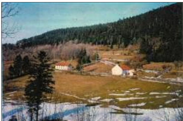
Vue du site, avec les maisons anciennement Stooz (gauche) et Colin (droite).
