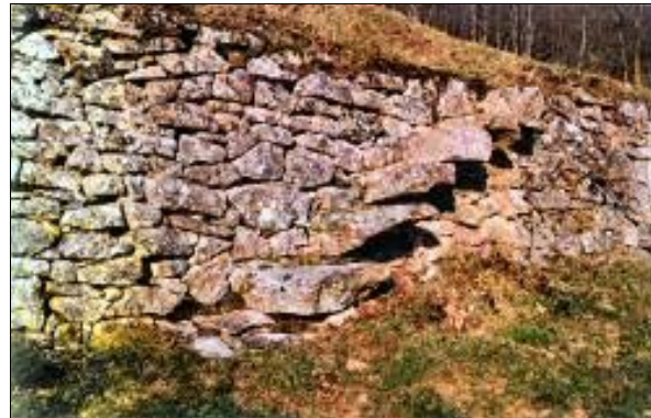
Escalier d'accès avec des marches parfois en encorbellement
