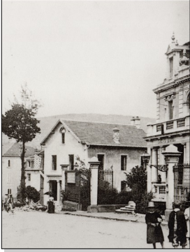
Figure 13 — On finit de construire la nouvelle maison BRUANT.
