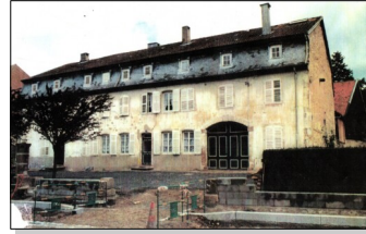
Figure 27 — 14, rue de l'Église, la Grande maison MENGIN (avant les travaux)
