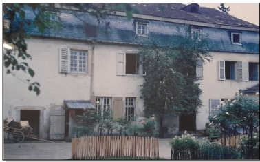
Figure 29 — Vue arrière. Noter les barreaux aux fenêtres du bas
