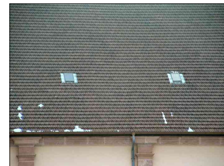
Illustration 6 : Les nouveaux châssis à tabatières.
