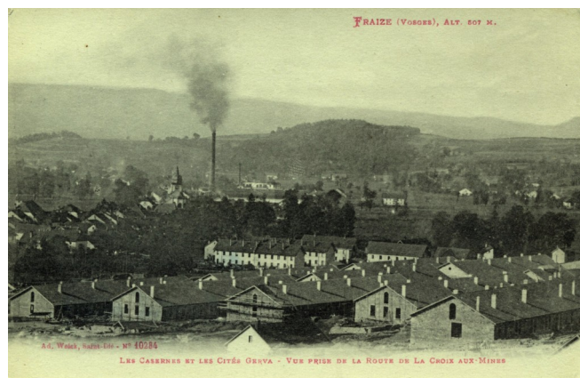
Vue des casernes en fin de construction sans le bâtiment du mess ni le pavillon de l'Hôpital.
