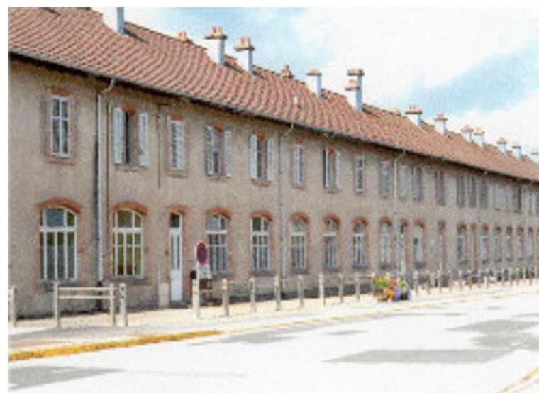
Le bâtiment de l'école de Filles Jules Ferry
