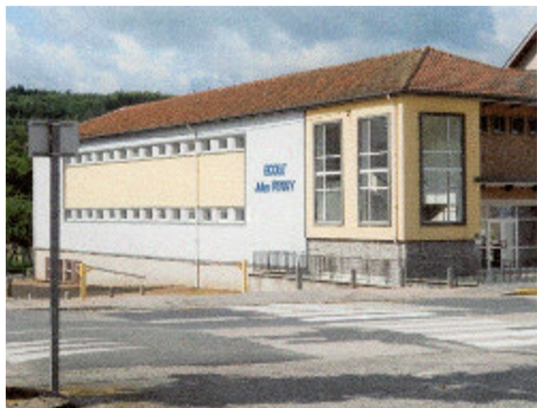
Le bâtiment du Collège d'Enseignement Général
