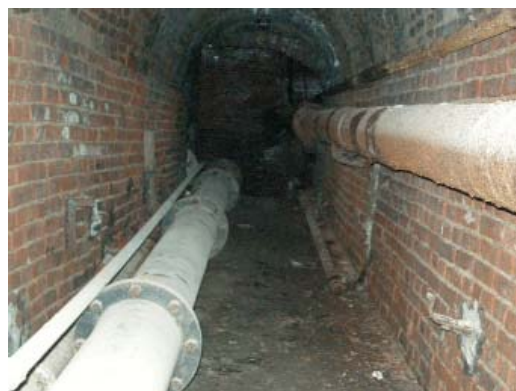
Monument historique : Tunnel, tuyauteries d'aspiration des pompes
