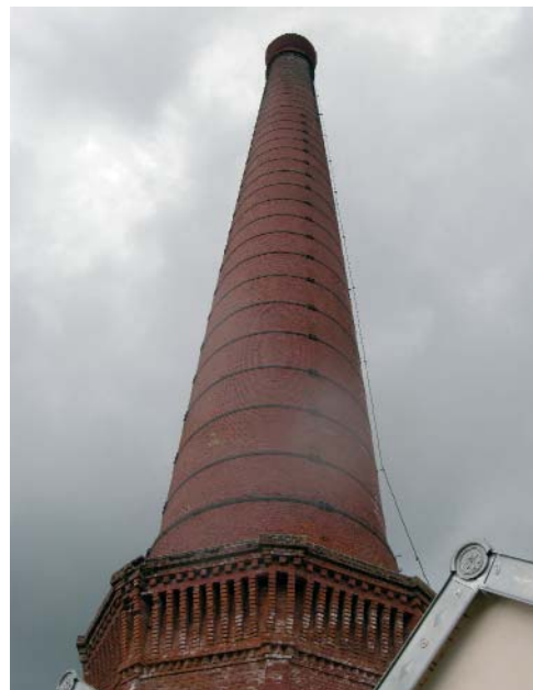
Monument historique : Cheminée filature des Aulnes
