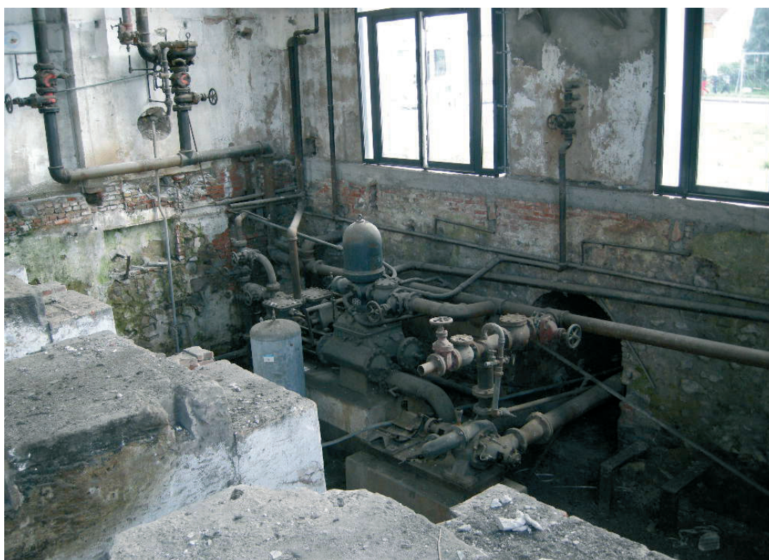
Pompe à vapeur Mather & Platt Limited "underwriter", pompe électrique SW (Schneider-Worthington).
