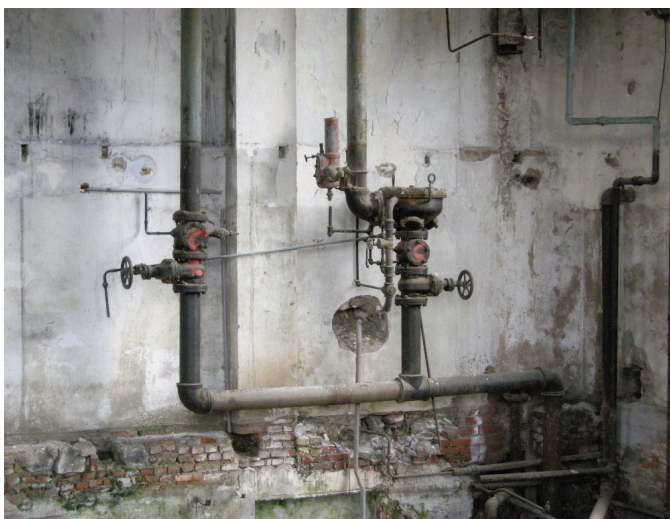
Fraize, postes de contrôle sous eau et alternatif (air et eau) Etat 2014.
