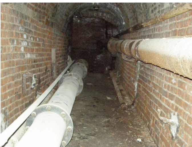
Tunnel relié à un puits communiquant avec la Meurthe. Etat 2014.
