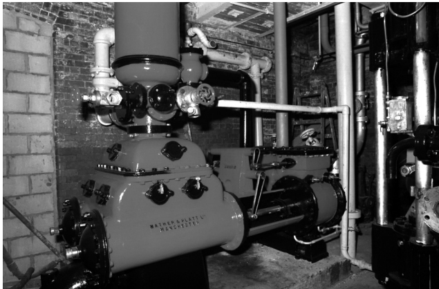
Pompe à vapeur Mather & Platt Ltd. Source d'eau de l'installation de sprinkler filature d'Ellenroad, Angleterre. L'installation de sprinkler a été démontée, la pompe est active grâce à une alimentation en vapeur.
