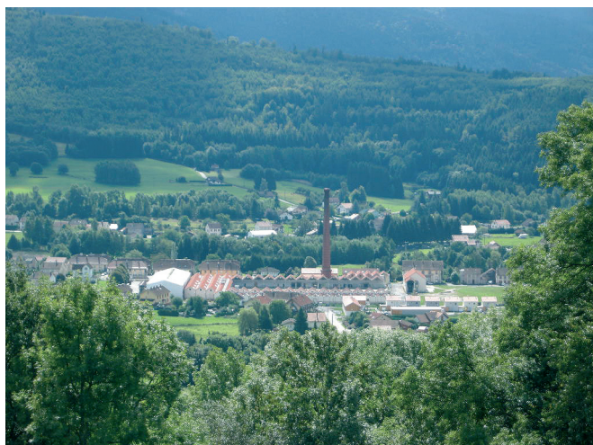
Filature des Aulnes à Fraize réhabilitée (vue générale).
