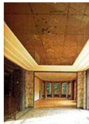
30 : Le plafond de la Villa Empain à Bruxelles.
