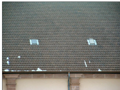
Illustration 6 : Les nouveaux châssis à tabatières.
