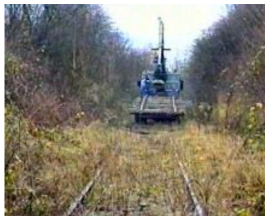
L'arrachage des rails de la voie dans la tranchée de Clairegoutte.
