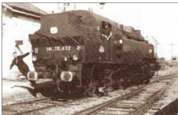
Une locomotive à vapeur 141 TB manœuvrant en gare de Fraize.
