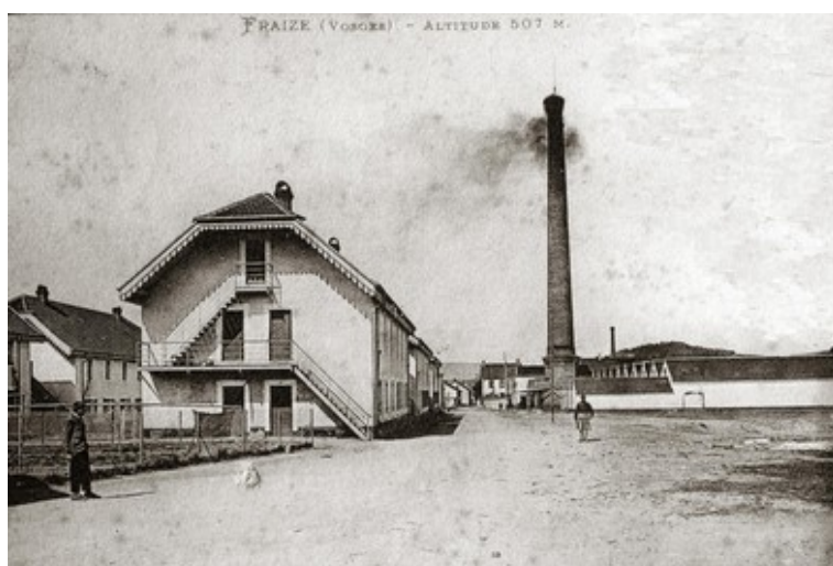
Vue vers l'ouest de la rue des Aulnes, avec à gauche les cités ouvrières et à droite la filature
